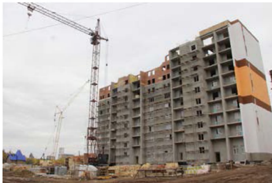
Строительство девятиэтажного МКД в 27 микрорайоне г. Белебее
